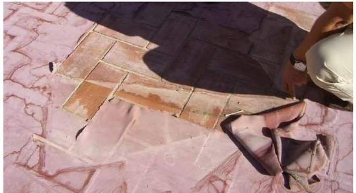
El producto aplicado se levantaba en varios sitios, ya que la humedad ascendente y la suciedad no permitían una adherencia duradera. La membrana se rompía en los bordes de las piezas de rasilla (donde había menos material), ya que no se realizó ninguna regularización de la superficie y no se aplicó una armadura capaz de homogeneizar espesores.
