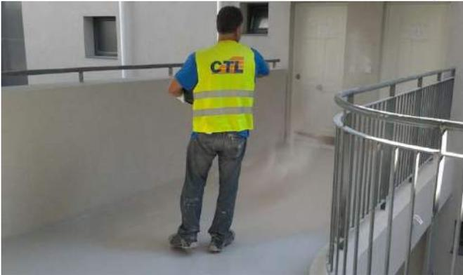
Se trata de áridos seleccionados con una dureza y granulometría especiales, totalmente compatibles con las membranas de poliuretano.
