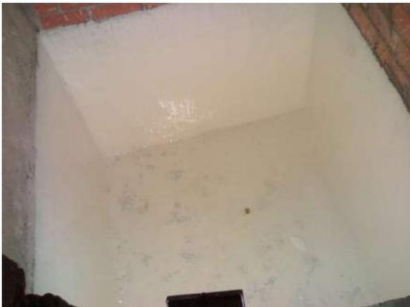
→ Foso de ascensor impermeabilizado con mortero bicomponente, posteriormente pintado con membrana de poliuretano.
