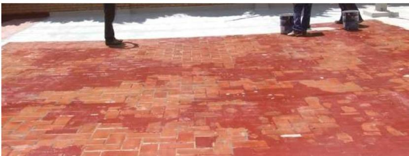
→ **ACRÍLICOS/MEMBRANAS DE POLIURETANO:** Al igual que en las telas prefabricadas, tendremos que quitar las partes mal adheridas al soporte.
