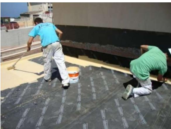
→ TELAS PREFABRICADAS: En este tipo de soportes tendremos que quitar las partes mal adheridas mecánicamente.
