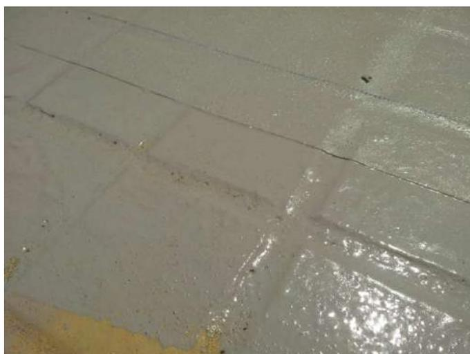
En esta superficie irregular de panots el geotextil garantiza un espesor homogéneo, evitando la creación de puntos débiles. →
