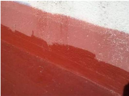
→ Aquí se aprecia como en la zona donde no se aplicó el Top Coat, la membrana de poliuretano aromático ha perdido el color (es resistente a los rayos UVA pero no estable).
