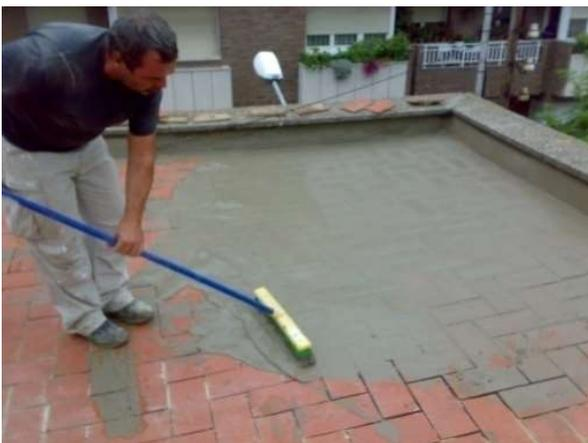
→ RASILLA: En las cubiertas de rasilla es conveniente recolocar las piezas mal adheridas; también se debe realizar una lechada de cemento en el caso de que las juntas sean muy hondas, para dejar una superficie llana.
