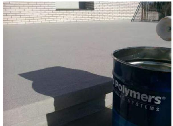
**Espolvoreo:** Se esparce una pequeña cantidad de árido de forma homogénea por la superficie, en este caso la superficie no quedará completamente llena de arena (creando un efecto antideslizante pero sin aumentar demasiado la dureza). El consumo aproximado estará entre 0,3 y 1 Kg./m<sup>2</sup>, para sellarlo solamente será necesaria una capa de Top Coat (si se precisa sellarlo).
