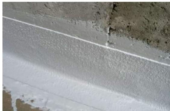
4)- Consigue **homogeneizar espesores** en toda la superficie de la membrana una vez seca independientemente de las superficies irregulares, desniveladas, fisuradas, etc.
