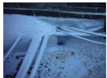
Las membranas líquidas permiten la impermeabilización de zonas difíciles. →
