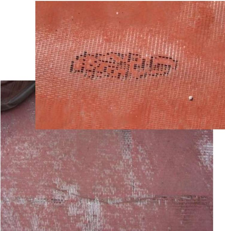
→ Aplicaciones de membranas líquidas con armaduras incorrectas
