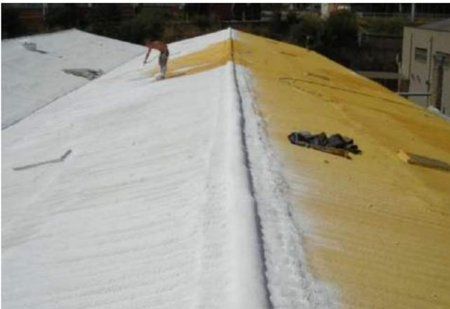
→ ESPUMA DE POLIURETANO: No precisa imprimación, totalmente compatible con las membranas de poliuretano líquido.
